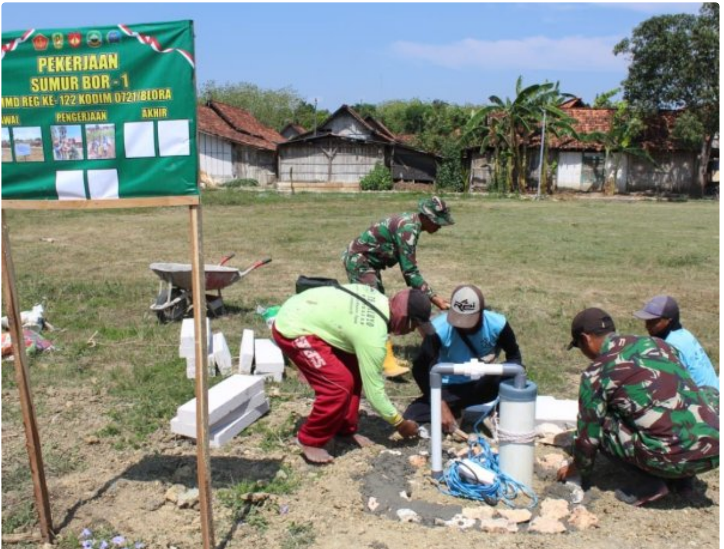
Foto: Anggota Satuan Tugas TNI Manunggal Membangun Desa (TMMMD) 122 Kodim 0721/Blora berkolaborasi dengan warga Desa Sidomulyo untuk melanjutkan pembuatan batu hebel pelindung pipa sumur bor, pada Minggu, 20 Oktober 2024.
