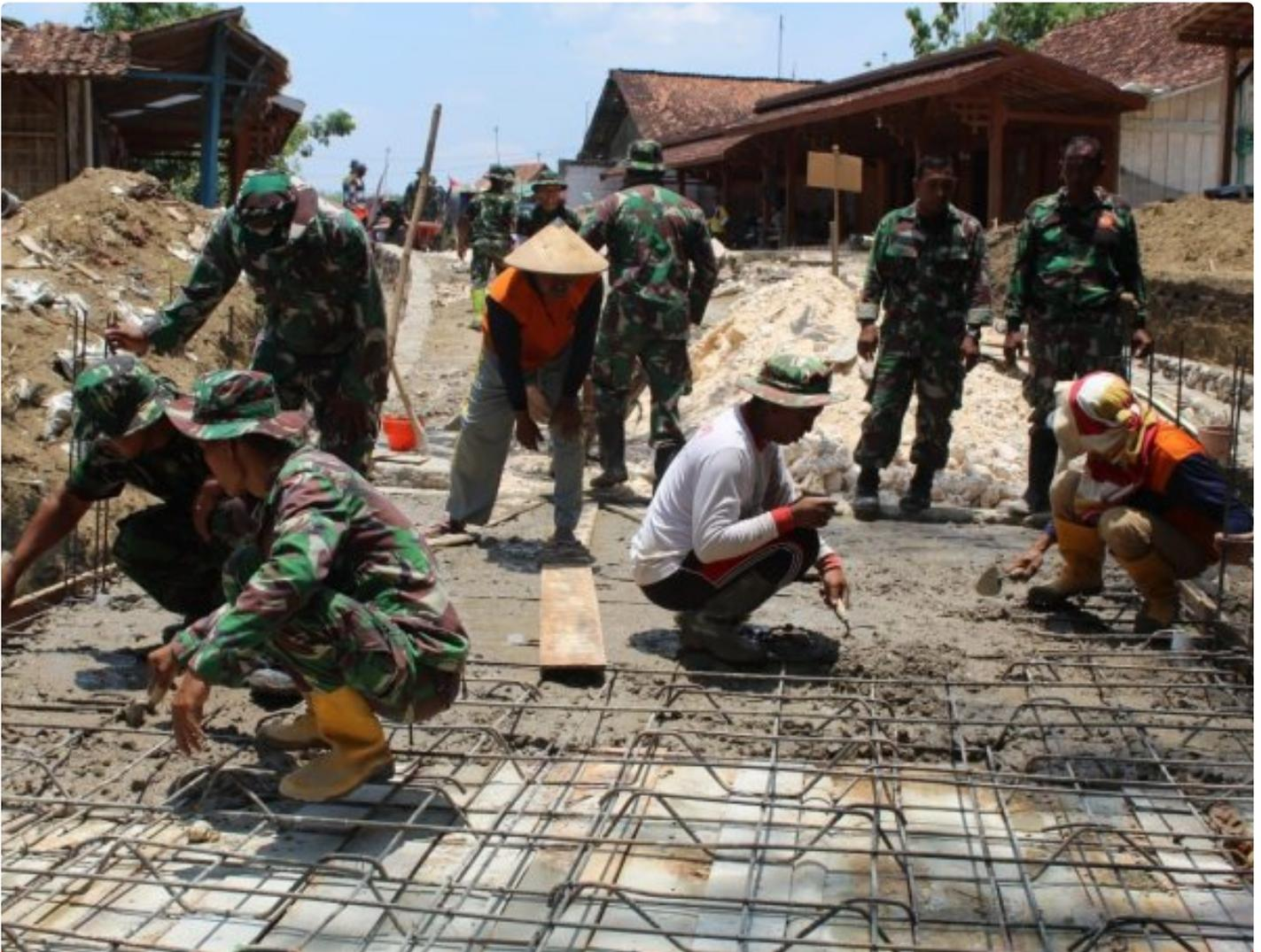
*Foto: Anggota Satgas TMMMD dan warga Desa Sidomulyo, Kecamatan Banjarejo, berkolaborasi dalam pengecoran jembatan di Dukuh Kedung Kenongo pada Jumat (11/10/2024).*
